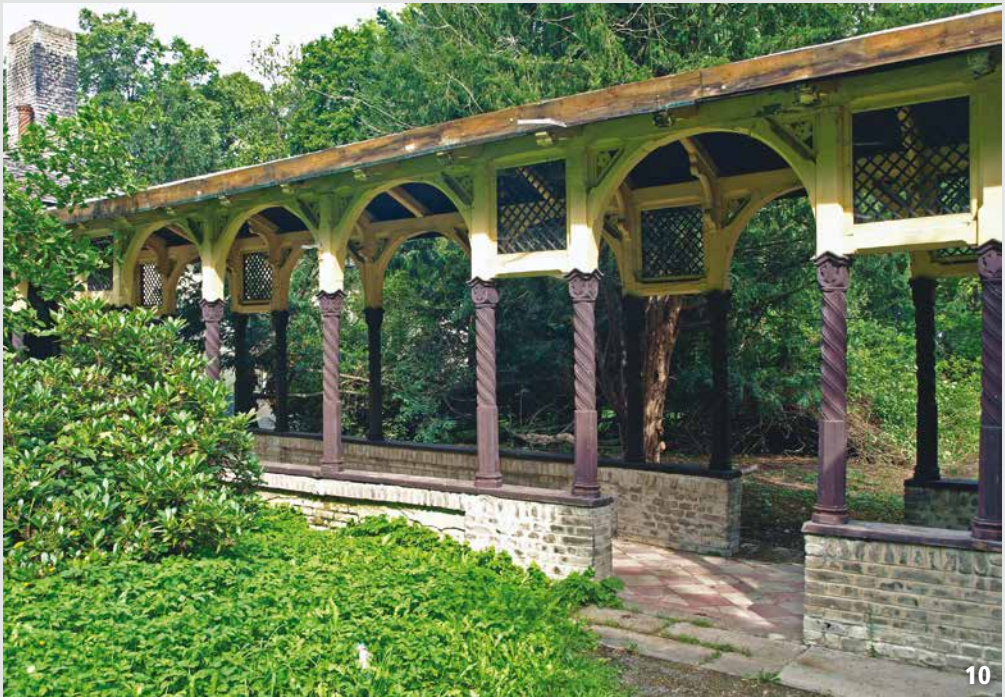
Obr. 9: Lysice (okres Blansko) – schodiště v zámeckém parku postavené v kombinaci kamenného a cihelného zdiva (foto Jan Pešta, 2015)
