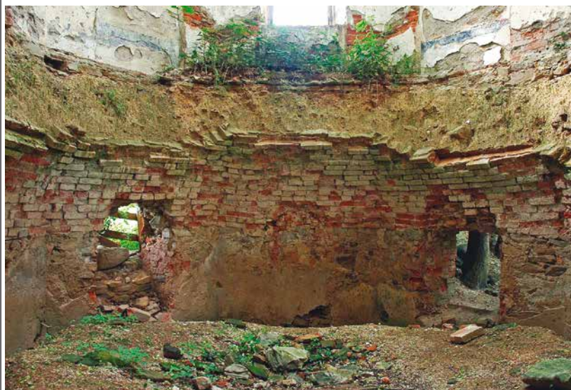
Interiér přízemí (foto Jan Pešta, 2007)
