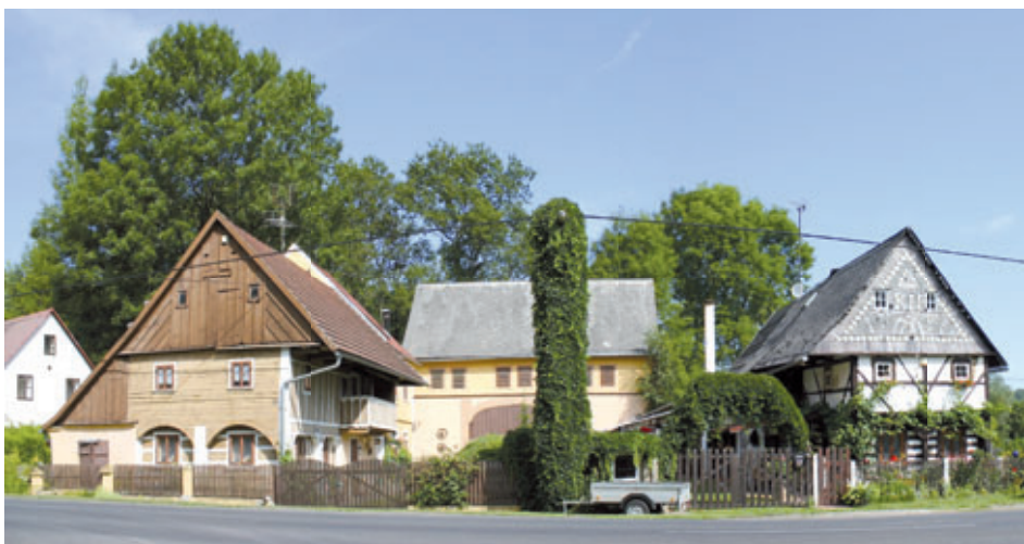
Dochovalé příklady lidové architektury ve Vědlicích.
