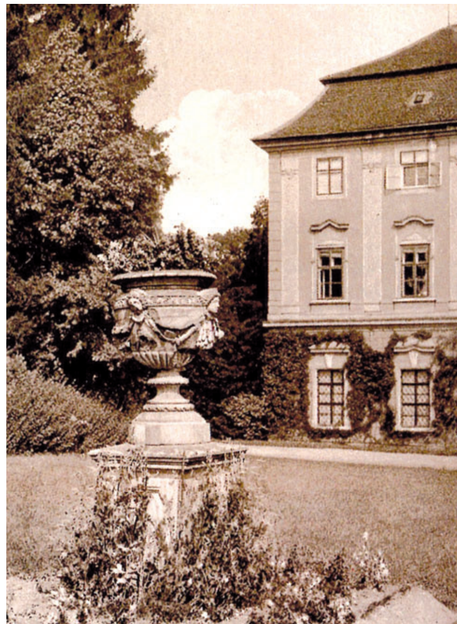
Pohled ze zámeckého parku v Liběšicích z roku 1943.
