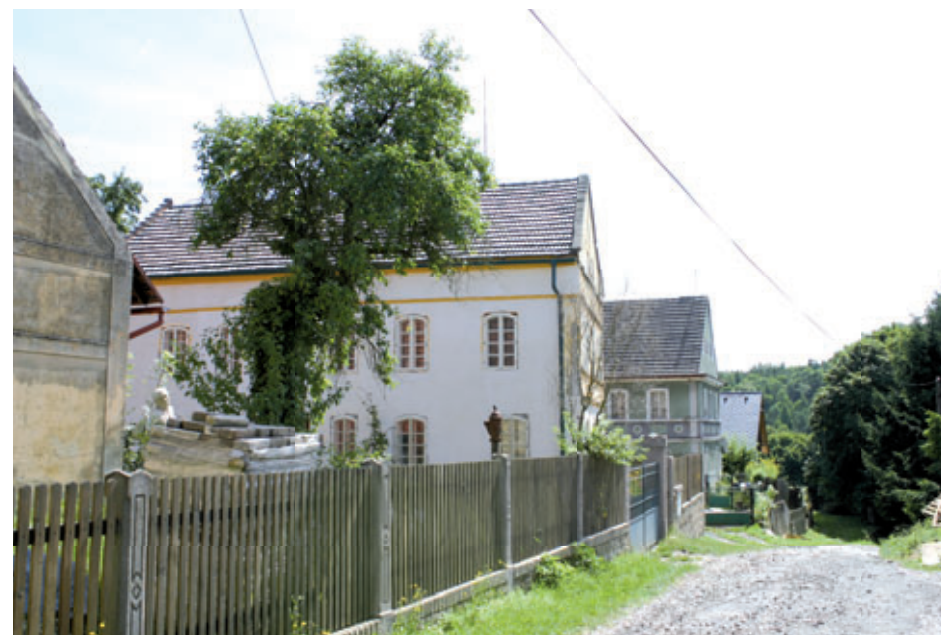
Zachovalá lidová architektura v obci Bylochov.
