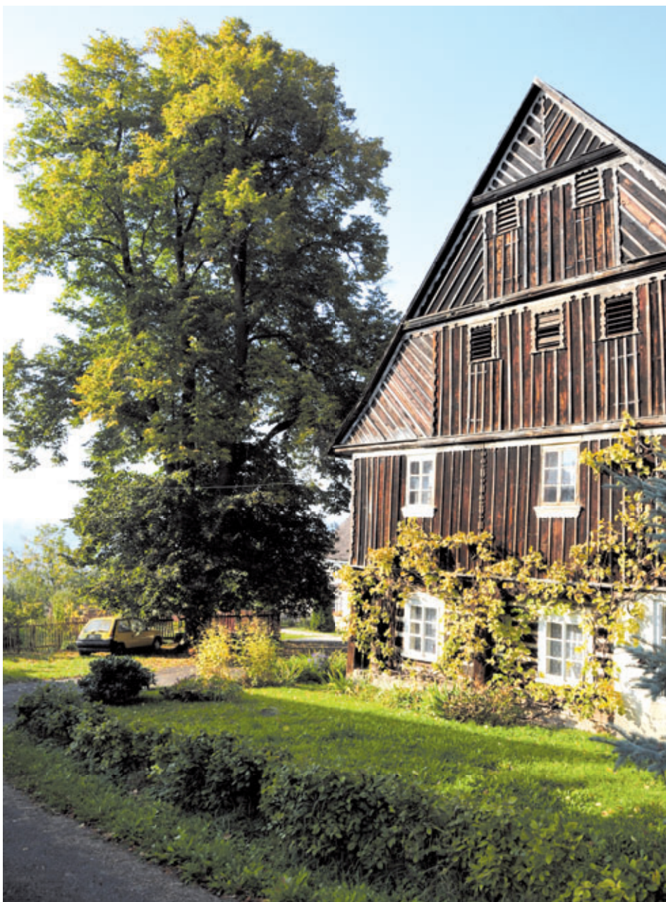
Lidová architektura spolu s typickým projevem lidového krajinářství – mohutný strom v blízkosti obytné budovy a treláž s vinnou révou.
