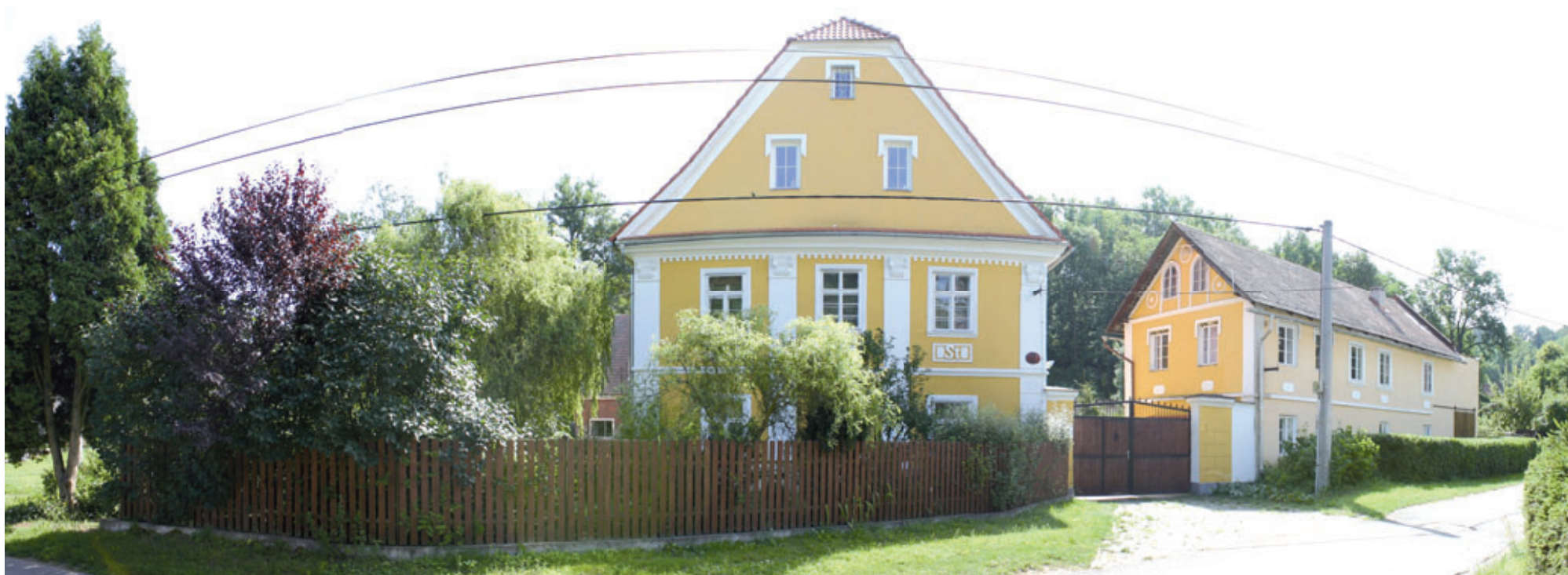
Dochovalé příklady lidové architektury ve Vědlicích.
